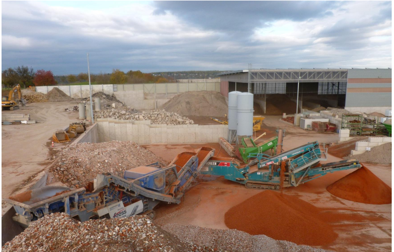
Brechen und Absieben des Materials auf Korngröße 2/16
